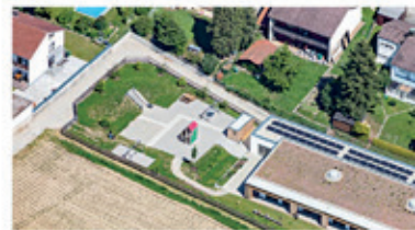
Fußweg am „Kindergarten am Kornfeld“
