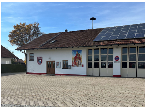
Feuerwehrhaus im Westen des Planungsgebietes.
