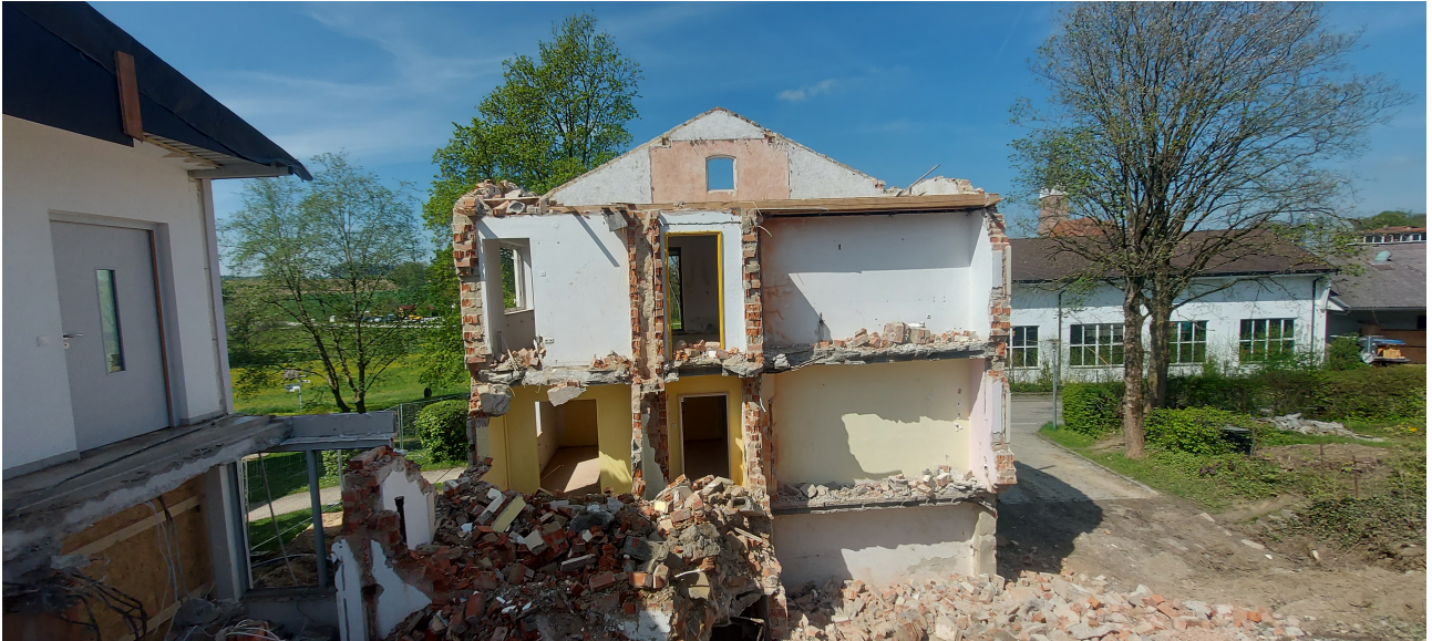
Das Foto zeigt den Abriss des früheren Lehrerwohnhauses in Pauluszell
